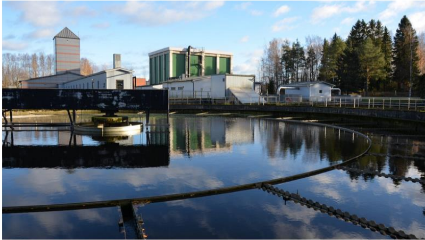
Seinäjoen Voima muuttaa jätevettä kaukolämmöksi
