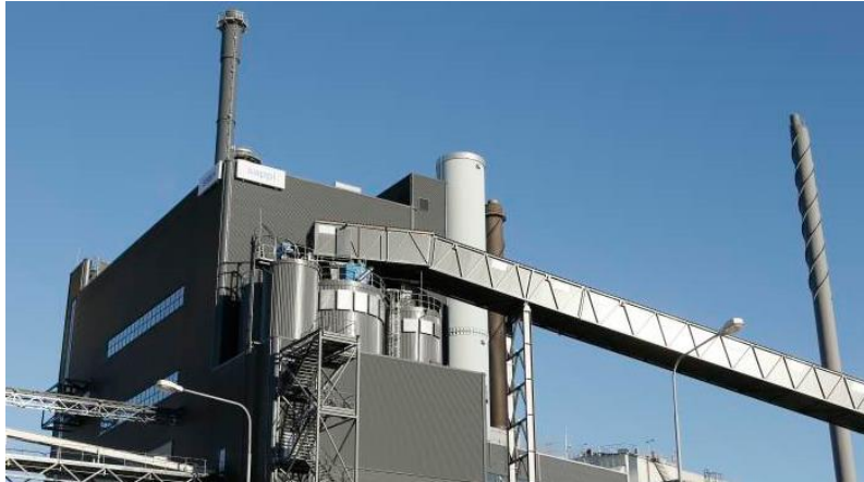
Monipolttoaine kiertoleijupetikattila (CFB) 2014–2015 56 m€
