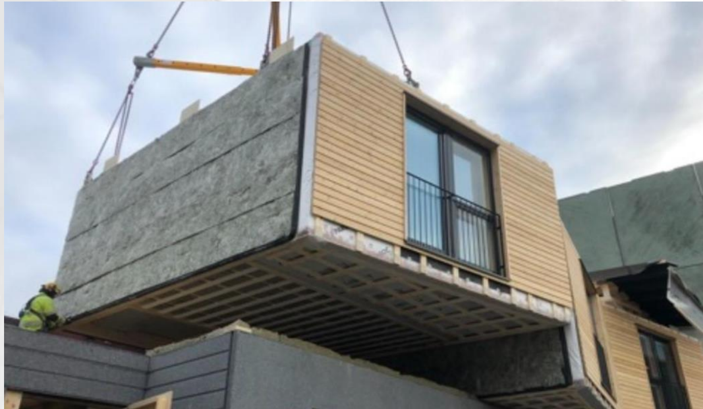
JULKISIVUN OSITTAINEN ESIVALMISTAMINEN
