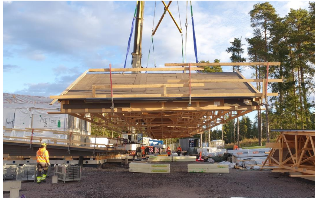
Sipoon Kalliomäenkaaren kaksi puukerrostaloa valmistuivat 2021 moduulitekniikalla alle kymmenessä kuukaudessa. Pääurakoitsijana toimi KW-Component Oy.
