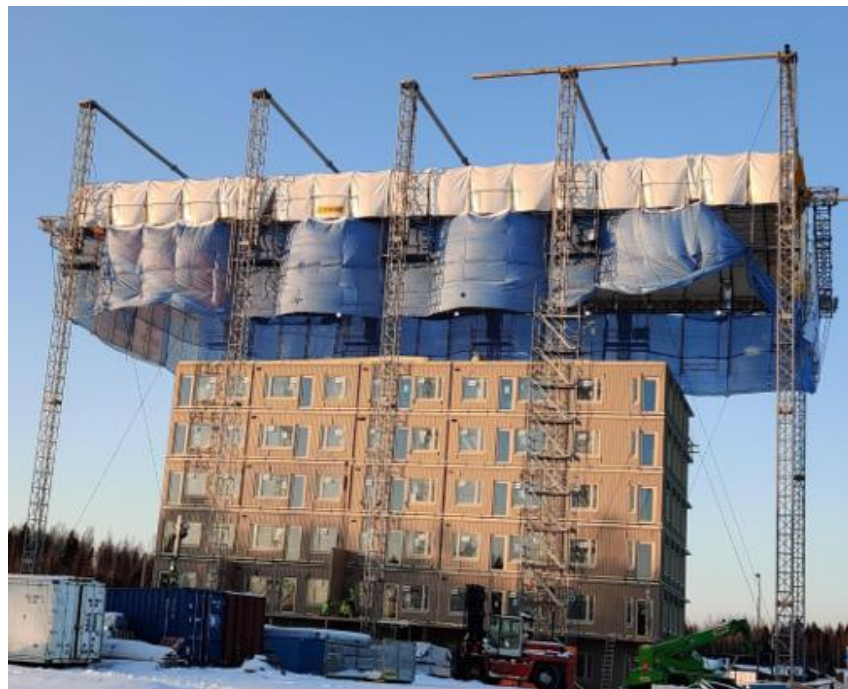
Tampereen Vuorekseen valmistui 2022 Suomen suurin puukerrostalohanke 13 600 m 2 , josta A-Kruunu rakennutti 3 taloa, yhteensä 92 asuntoa. Kohteen toteutti Arkta Rakennus Oy puurunkorankaisina suurelementteinä.
