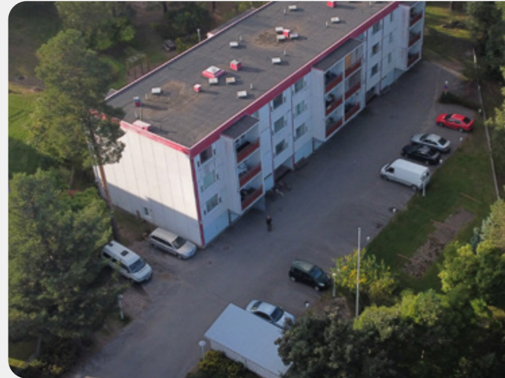
Kouvolan Asunnot. Puun hyödyntäminen korjausrakentamisessa ja rakennusosissa
