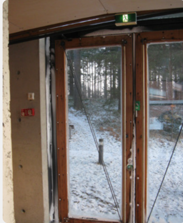
Hätäpoistumistie, lämpövuoto
