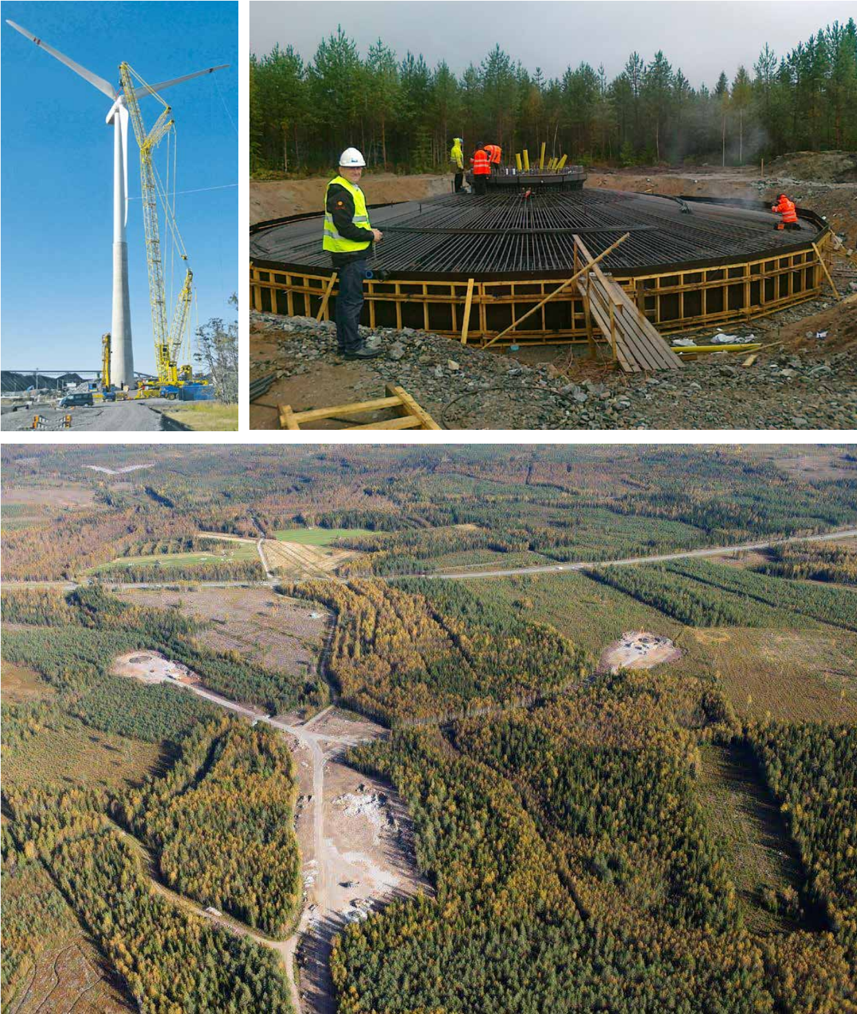
Kuva 1. Tuulivoimaloiden rakentamisvaiheita (Tuuliwatti Oy).
