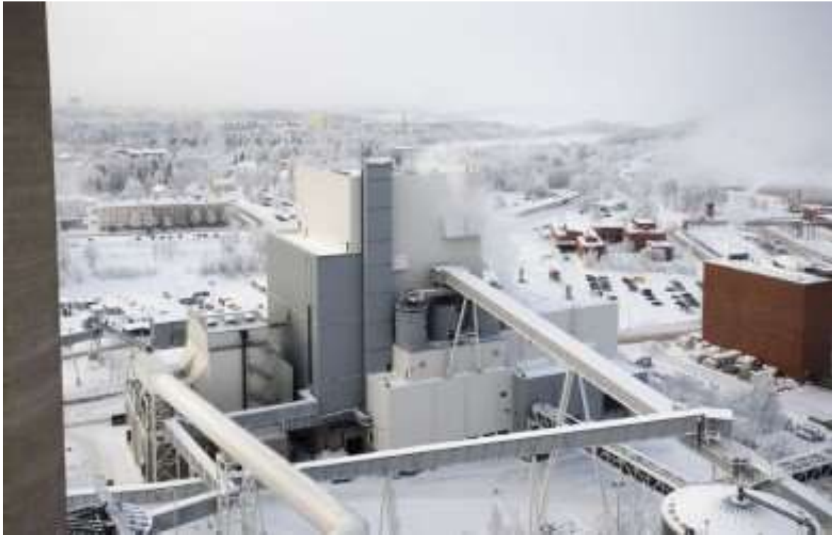
Kuva 7. Kaukaan Voima Oy (KauVo) (Pohjolan Voima 2018)
